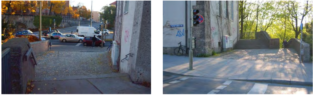
Abbildung 4-20: Treppe an den Radhaupttrouten über den Giesinger Berg
