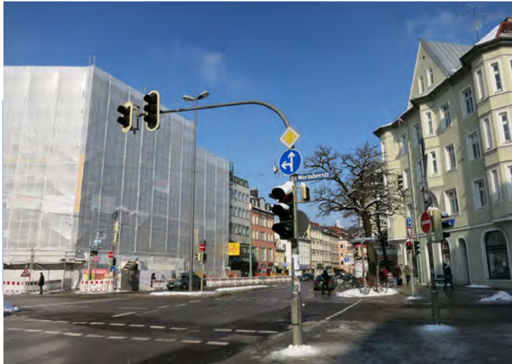
An der TeLa 64 entsteht ein neues Geschäftsgebäude mit Kaufhaus, Supermarkt und Drogerie.
